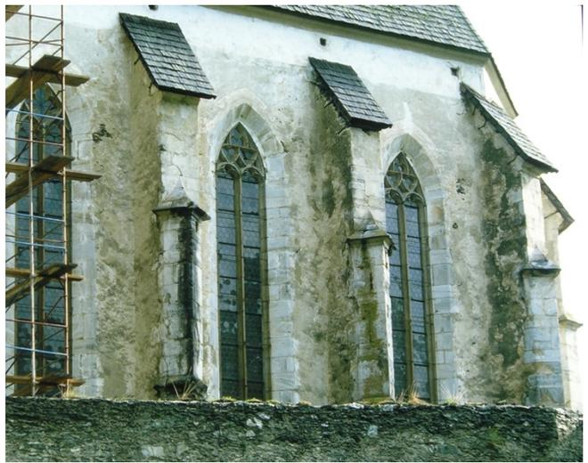
Abb. 3. Grades, Wallfahrtskirche St. Wolfgang (1453-74), Chor, Südfassade. Spuren der Wiederverwendung der Netzriegellöcher für Reparaturgerüste. Foto: Hammer 1986
