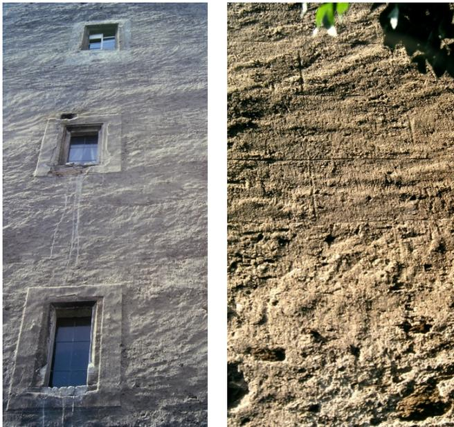
Abb. 1 a, b. Krems / Niederösterreich, Passauer Hof, Turm, ursprünglicher Verputz 15. Jh., einschichtig auf Bruchsteinmauerwerk., rau abgezogen und abgekellt, regelmäßige Fugenmalerei; a: Gerüstgrenzen, Fächerstruktur; b: Detail: Faktur, Überlagerung von 4 Texturen: Maueroberfläche, Kellenabzug, Abkellen, Fugenmalerei. Fotos Hammer 1979
