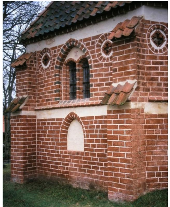
Abb. 13. Bokel Kr. Gifhorn / Niedersachsen, Johanneskapelle, datiert 1471. Konservierung und Restaurierung der Ziegelmalerei 1997. Das Traufenwasser fließt auf der leicht abschüssigen Grasnarbe vom Sockel weg. Foto: Hammer 1999
