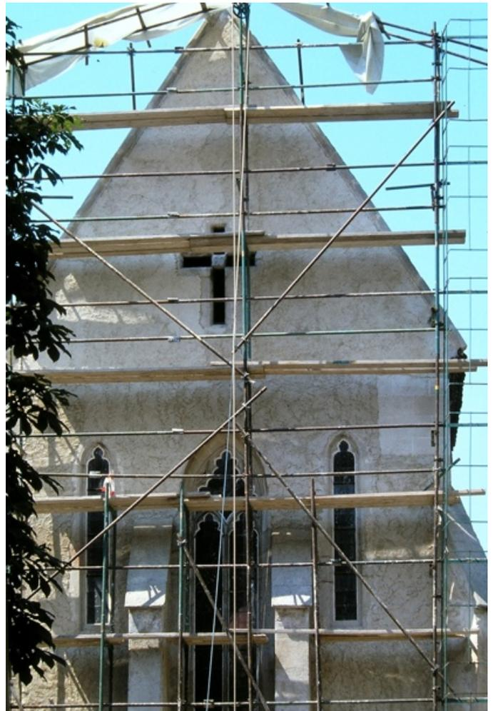
Abb. 14 a. Krems, Passauer Hof, Ursulakapelle, um 1300, Ostfassade. Kompressenputz nach Reinigung mit Hirschkornsalz
