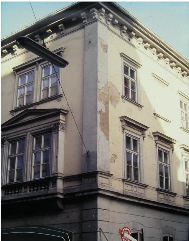
Abb. 6. Klagenfurt / Kärnten. Die mit Kunstharzfarbe gestrichene Fassade ist durch thermische Dilatation und entsprechende Scherspannungen auf der Südseite stärker beschädigt als auf der Westseite. Foto: Hammer 1979
