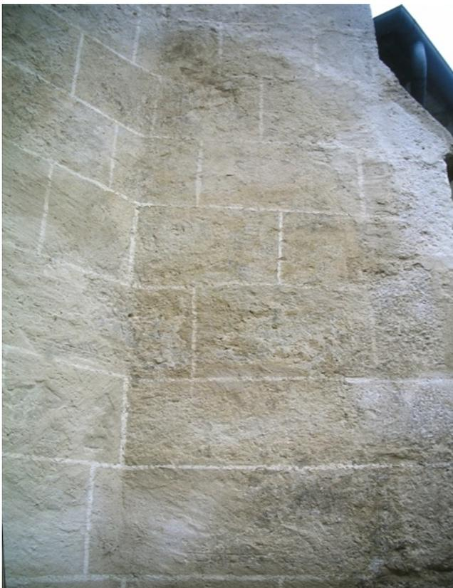
Abb. 14, b – c. Krems, Passauer Hof, Ursulakapelle, um 1300, Ostfassade; a: Kompressenputz nach Reinigung mit Hirschhornsalz; b: nach Konservierung und Reparatur 1991; c: Detail der konservierten und reparierten Oberfläche. Foto Hammer 1991
