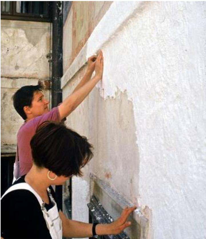
Abb. 23: Forchtenstein / Burgenland, Burg, innerer Hof, Fassadenmalerei 1687, Ostfassade. Abnahme der letzten Salzverminderungskompresse nach Behandlung mit Hirschhornsalz und Ammoniumcarbonat. Foto Hammer 1993
