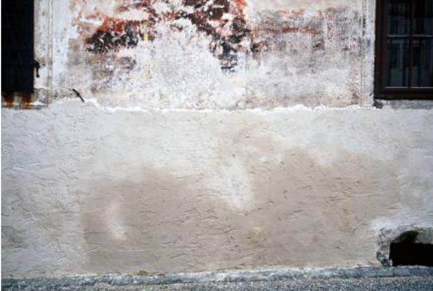
Abb. 20: Forchtenstein / Burgenland, Burg, innerer Hof, Fassadenmalerei 1687, Südfassade, Detail. Mit Mörtel stabilisierte Zellstoffkompreße im gesamten Sockelbereich, von Baufirma (Mild) appliziert. Foto Hammer 1992
