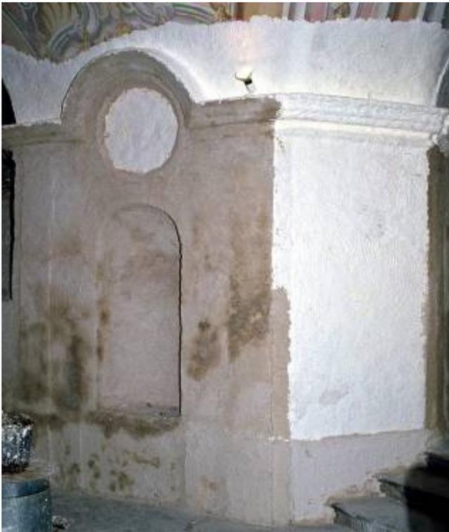
Abb. 15: Dürnstein / Niederösterreich, ehem. Stiftskirche, Krypta, Verputz, Kalksandstein, Stuck, Wandmalerei 17./18. Jh., Salzverminderung mit verschiedenem Kompressenaufbau: auf Wandmalerei, Stein und Stuck Japanpapier und Zellstoff, teilweise stabilisiert mit Kalkmörtel; auf Verputz Polyamidvlies und Kalkmörtel. Die hygroskopischen Flecken und "Verfressungen" des Kompressenverputzes zeigen die Wirkung der Methode. Foto Hammer 1987
