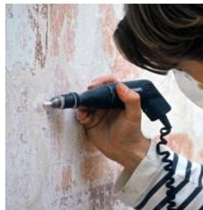
Abb. 8 und 9: Forchtenstein / Burgenland, Burg, innerer Hof, Ostwand, Fassadenmalerei 1687. Versinterte und vergipste Übertünchungen, Oxalatfilm. Mechanische Entfernung mit Mikromeißel und rotierender Glasfaser. Foto Hammer 1993
