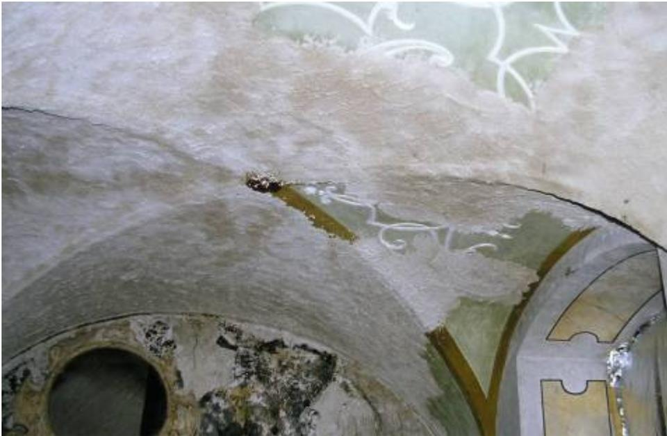
Abb. 18: Dürnstein / Niederösterreich, ehem. Stift, Kreuzgang, Stuckdecke 18. Jh., Schäden durch Wassereinbruch. Salzverminderung mit Kalkmörtel, die Leimfarbe auf dem Kalkstuck dient als Trennschicht. Foto Hammer 1987
