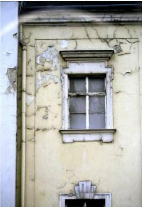
Abb. 3: Wien 1, Schottenkirche, Langhaus, Südfassade, Detail. Durch Schäden an der Dachdrainage ist der Verputz mit Salzen kontaminiert. Durch den filmbildenden Anstrich kristallisieren die Salze hinter der Oberfläche. Der Verputz verwittert unter dem Anstrich. Foto Hammer ca. 1985
