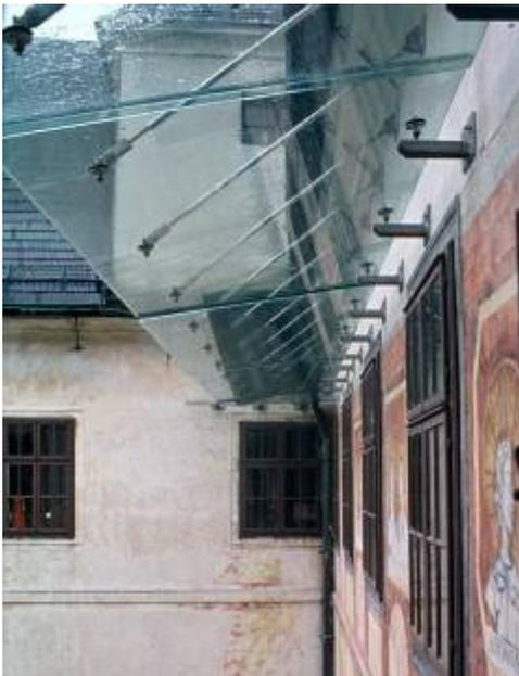
Abb. 4: Forchtenstein / Burgenland, Burg, innerer Hof, Fassadenmalerei 1687. Durch ein modernes Glasdach wird der Einfluß normaler Verwitterung auf die Fassadenmalerei verringert. Foto Hammer 1993
