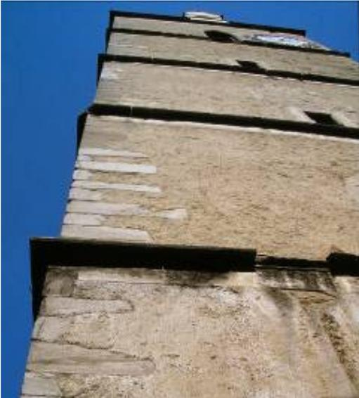
Abb. 2: Weissenkirchen / Niederösterreich, Pfarrkirche, Hauptturm, Westfassade, rau abgezogener, einschichtiger Verputz von 1502 auf Bruchsteinmauerwerk, vor der Konservierung. Durch die Wasserschlaggesimse ist der Verputz gegen übermäßige Feuchtigkeit geschützt. Wo dieses Gesims beschädigt ist, beginnen die Schäden durch Vergipsung. Foto Hammer 1989
