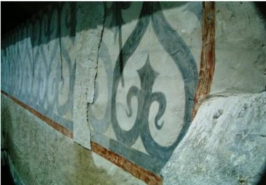
Abb. 21: Grades / Kärnten, Filiationkirche 15. Jh., Südfassade, Detail, Flecken von hygroskopischen Salzen an der fertig restaurierten Fassade nach Wassereintritt während Dacherneuerung. Mörtelkompreße zur Salzverminderung (während Herstellung). Foto Hammer 1986
