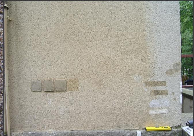
Mörtelkonfektionierung: Kalk, Sandaufschlämmung, Kalksplitter (kein industrielle hergestellter Trockenmörtel)
